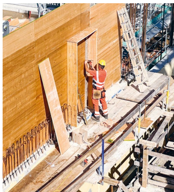
Feine Maserungen im Sichtbeton dank den präzisen Holzverschalungen.
