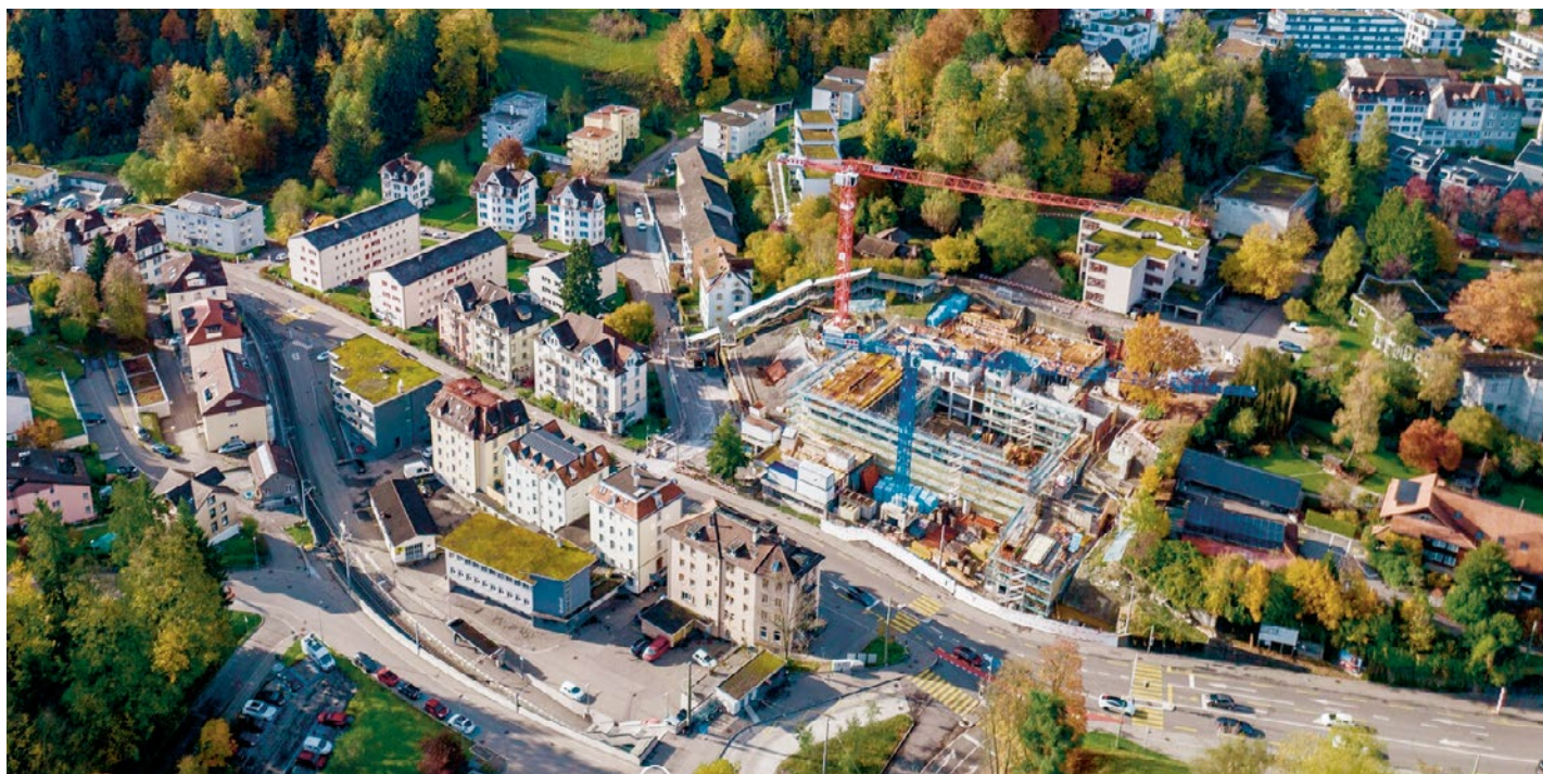
Hier wächst das neue Schulhaus in die Höhe. Drohnenaufnahme: Roger Zahner
